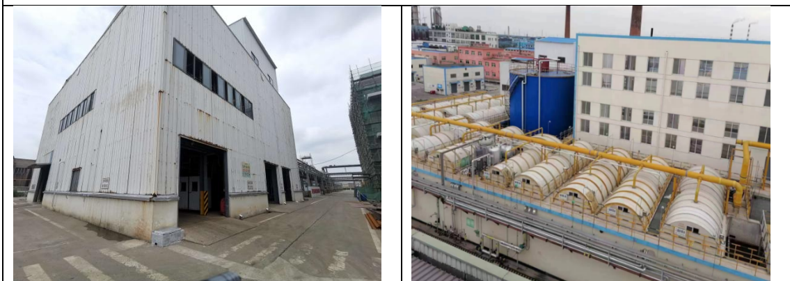
储罐区：罐区内储罐均为地上储罐，并设置有围堰，储罐间使用围堰相隔，围堰完好无破损。
