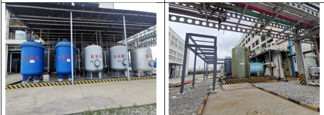
储罐区：罐区内储罐均为地上储罐，并设置有围堰，储罐间使用围堰相隔，围堰完好无破损。
